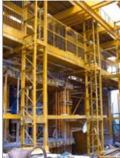
「滑爬模」建築方法的地盤實景
