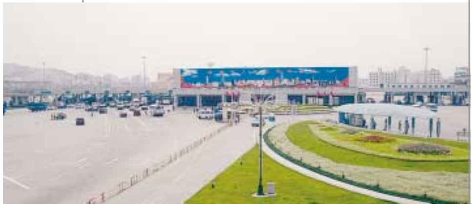
於廣深高速公路之同樂檢查站
