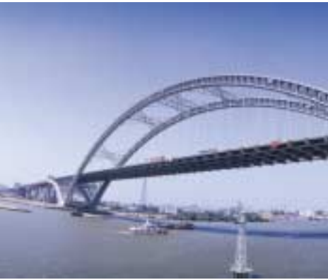
東南西環高速公路主橋— 丫髻沙大橋
