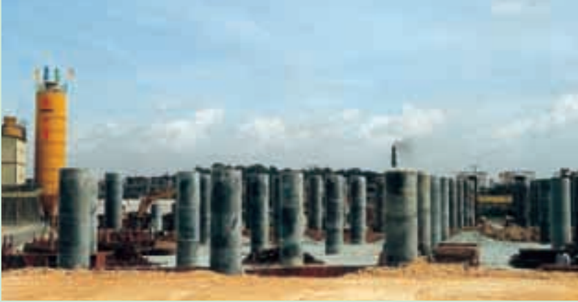
廣珠西線高速公路第一期工程施工情況
